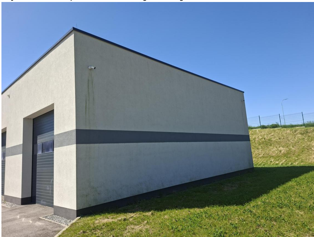
Zdj.1. Ściana budynku warsztatowo-garażowego
